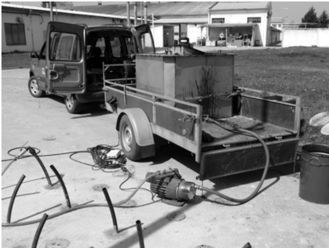
Obr. 2 Aplikace nanoFe do tělesa PRB 1b
